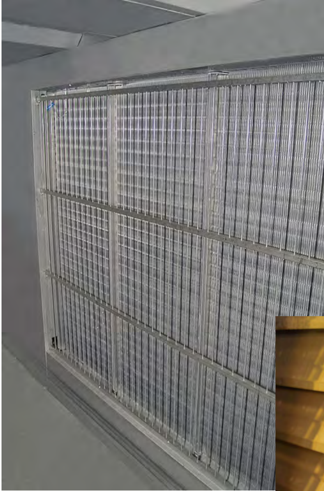
COSCHOCK FLASH Hochleistungsstandverdampfer
